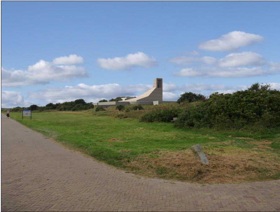
4. Standpunt op de Westerburenweg ter hoogte van de aansluiting van het Karrepad
